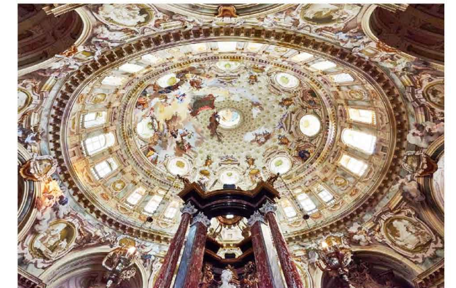
Santuario basilica Regina Montis Regalis di Vicoforte: cupola a sezione orizzontale ellittica più grande al mondo. Innalzata da Francesco Gallo negli anni 1728 - 1732, è alta 74 metri, lunga 37,15 metri sull'asse maggiore e 24,80 metri sull'asse minore.
